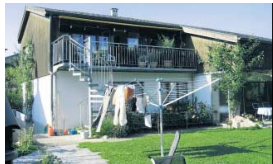
Haus am Zelweg vor dem Umbau.
