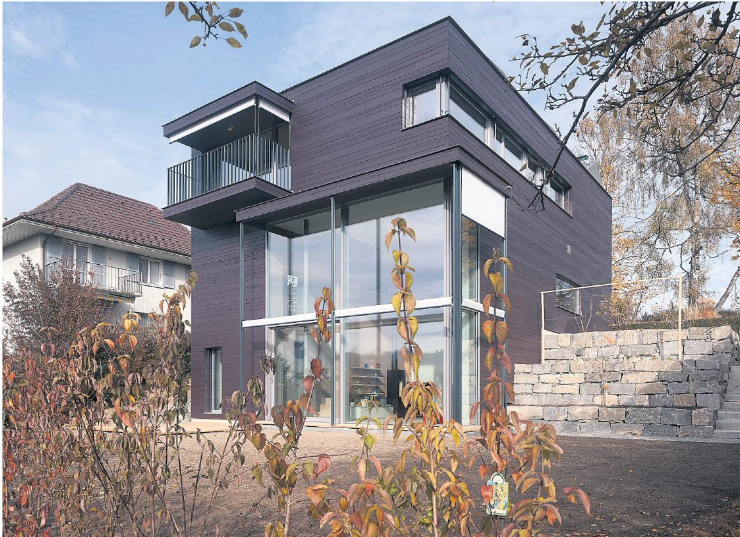
Plusenergiehaus Luchliweg: Der Baukörper wurde präzise in die engen Platzverhältnisse gesetzt
